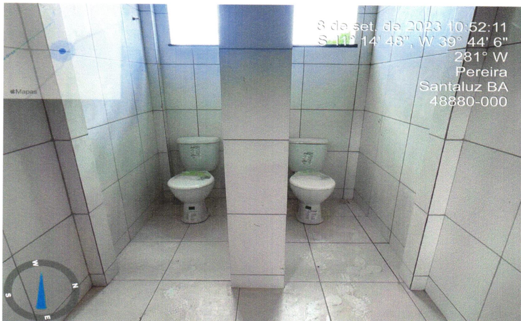
Foto 20 – VASO SANITÁRIO SIFONADO COM CAIXA ACOPLADA LOUÇA BRANCA - PADRÃO MÉDIO, INCLUSO ENGATE FLEXÍVEL EM METAL CROMADO, 1/2 X 40CM - FORNECIMENTO E INSTALAÇÃO. AF_01/2020.
