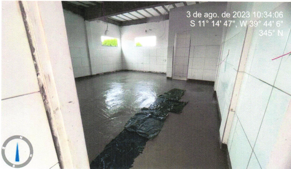
Foto 11 – Piso alta resistencia, cor cinza, e=10mm, aplicado com juntas, polido até o esmeril 400 e encerado, exclusive argamassa de regularização
