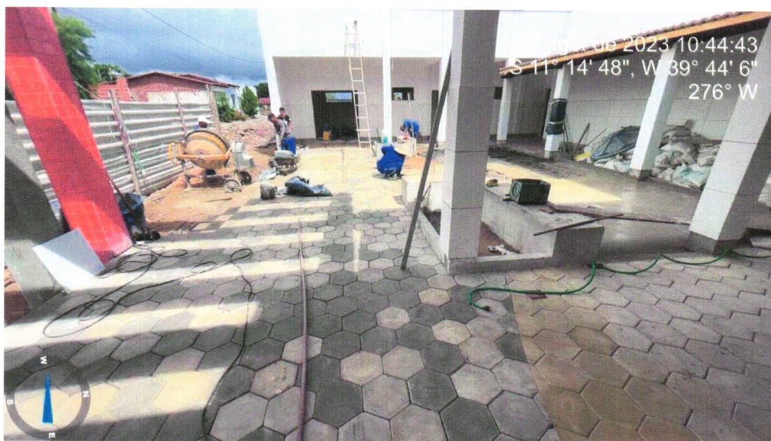
Foto 14 - EXECUÇÃO DE PAVIMENTO EM PISO INTERTRAVADO, COM BLOCO SEXTAVADO DE 25 X 25 CM, ESPESSURA 6 CM.(LARANJA, AMARELO, GRAFITE, NATURA) AF_12/2015
