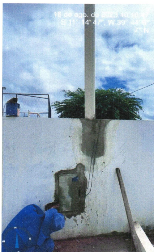
Foto 22 - Quadro de medição trifásica em Noril com lente para leitura.
