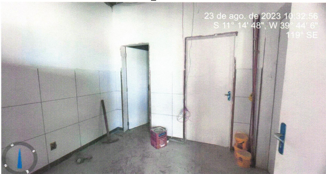
Foto 02 – KIT DE PORTA-PRONTA DE MADEIRA EM ACABAMENTO MELAMÍNICO BRANCO, FOLHA LEVE OU MÉDIA, 90X210, EXCLUSIVE FECHADURA, FIXAÇÃO COM PREENCHIMENTO TOTAL DE ESPUMA EXPANSIVA - FORNECIMENTO E INSTALAÇÃO. AF_12/2019
