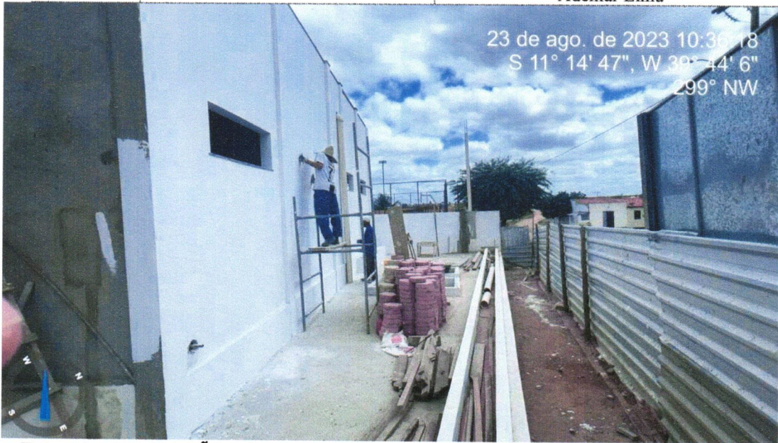
Foto 16 - APLICAÇÃO E LIXAMENTO DE MASSA LÁTEX EM PAREDES, UMA DEMÃO.AF_06/2014.
