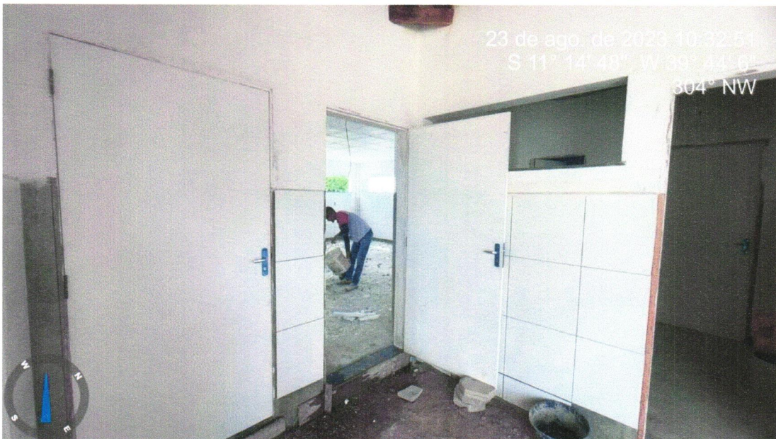
Foto 01 – KIT DE PORTA-PRONTA DE MADEIRA EM ACABAMENTO MELAMÍNICO BRANCO, FOLHA LEVE OU MÉDIA, 90X210, EXCLUSIVE FECHADURA, FIXAÇÃO COM PREENCHIMENTO TOTAL DE ESPUMA EXPANSIVA - FORNECIMENTO E INSTALAÇÃO. AF_12/2019
