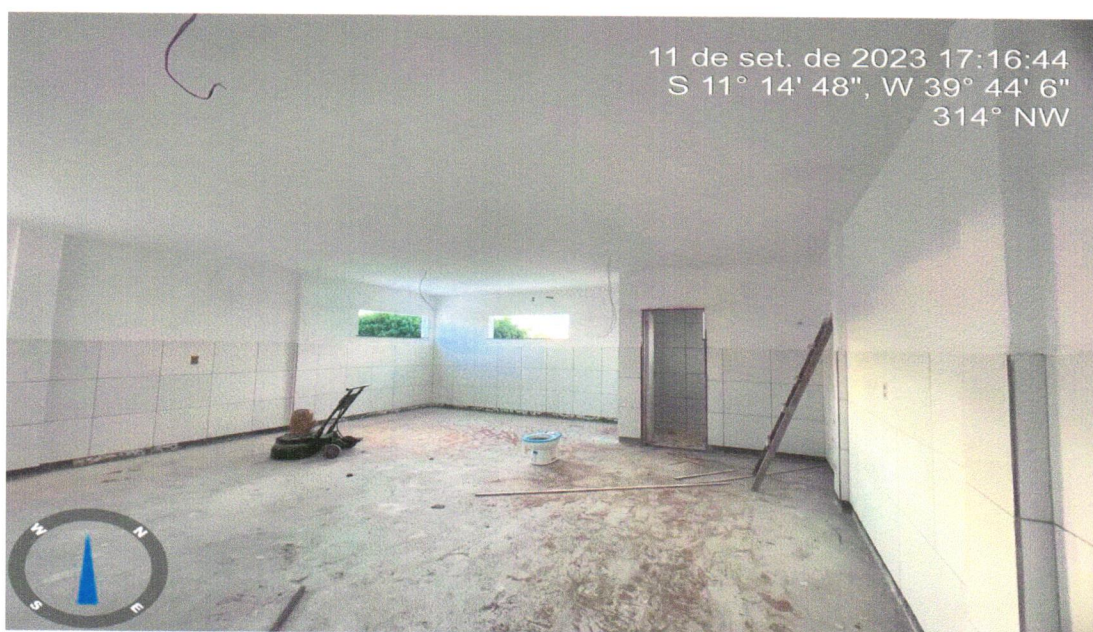
Foto 19 – APLICAÇÃO E LIXAMENTO DE MASSA LÁTEX EM PAREDES, UMA DEMÃO.AF_06/2014.
