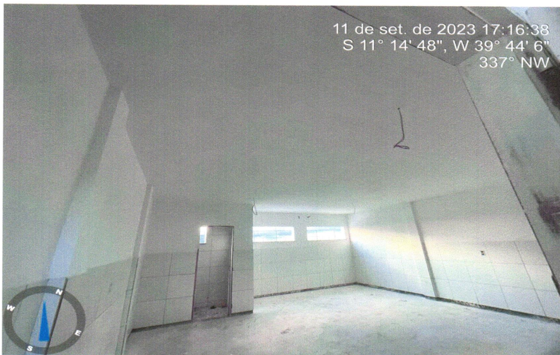
Foto 18 – APLICAÇÃO E LIXAMENTO DE MASSA LÁTEX EM PAREDES, UMA DEMÃO.AF_06/2014.
