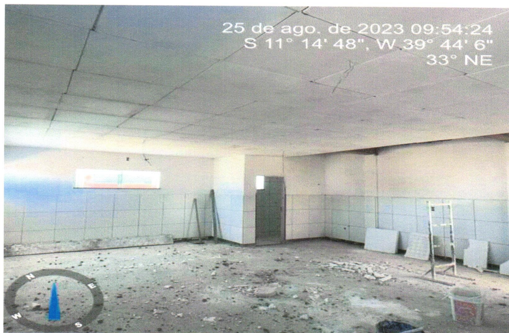
Foto 08 - FORRO EM PLACAS DE GESSO, PARA AMBIENTES COMERCIAIS. AF_05/2017_P
